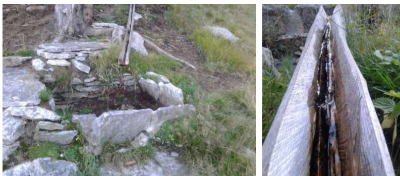
Vecchia vasca abbeveratoio in sasso e canale in legno per trasporto acqua
